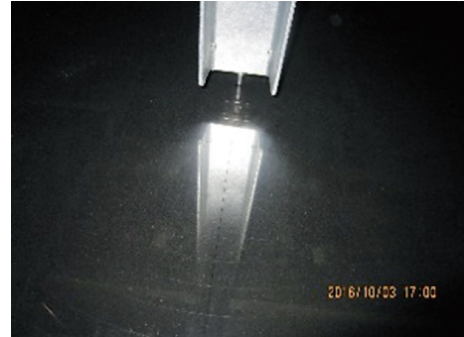
写真20 免震ピット野書き計
