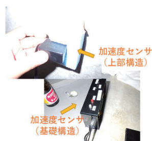
(b)免震層一設置状況
