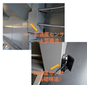
(b)免震層一設置状況
