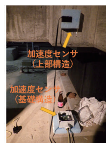
(b)免震層一設置状況
