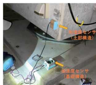
(b)免震層一設置状況
