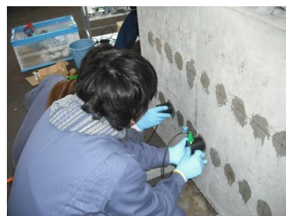
補修作業の様子
