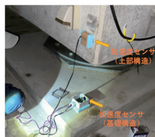
(b)免震層一設置状況
