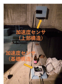
(b)免震層一設置状況
